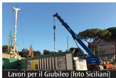
Lavori per il Giubileo (foto Siciliani)
